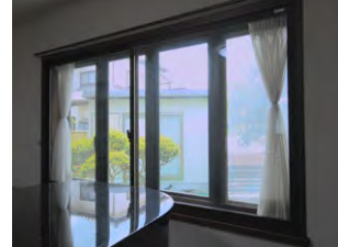
内窓設置を実施
