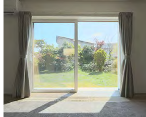
外窓交換(はつり工法)を実施
