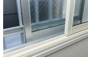
全住戸の内窓設置を実施
