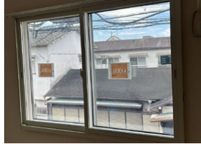
主居室の南側に内窓設置
